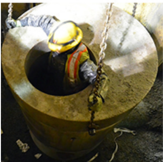
Manhole Lid set on Riser
