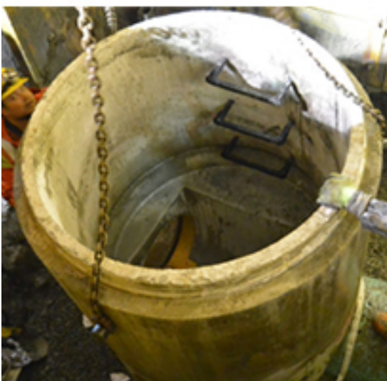
Manhole Riser set on Base
